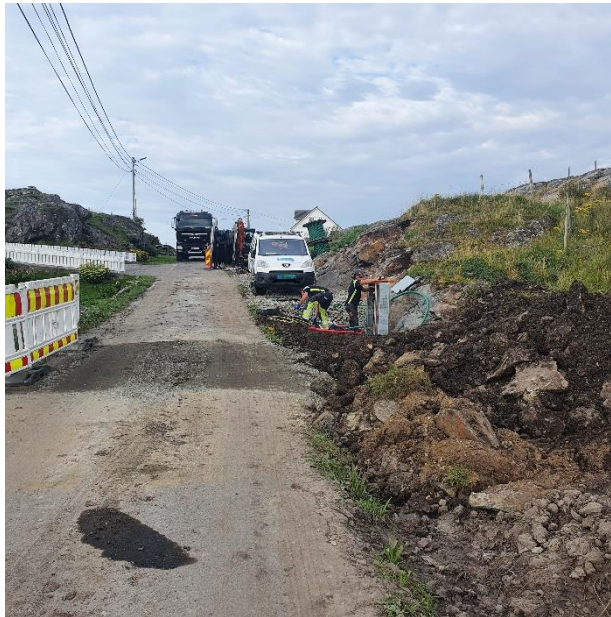
Bilde fra Austrheimsvegen der Haugaland Kraft legger ned høyspentledning og kommunen ny vannledning i traseen.
