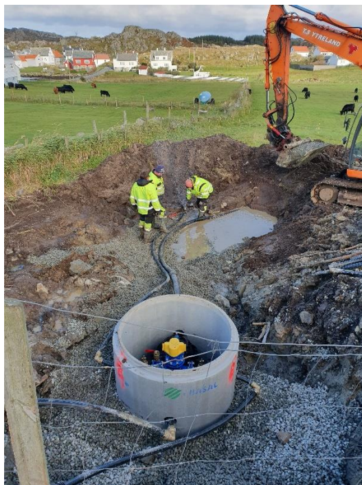
Foto: Arvid Helgesen, Reparasjon av vannlekkasje i Pedlevegen og ny brannkum
