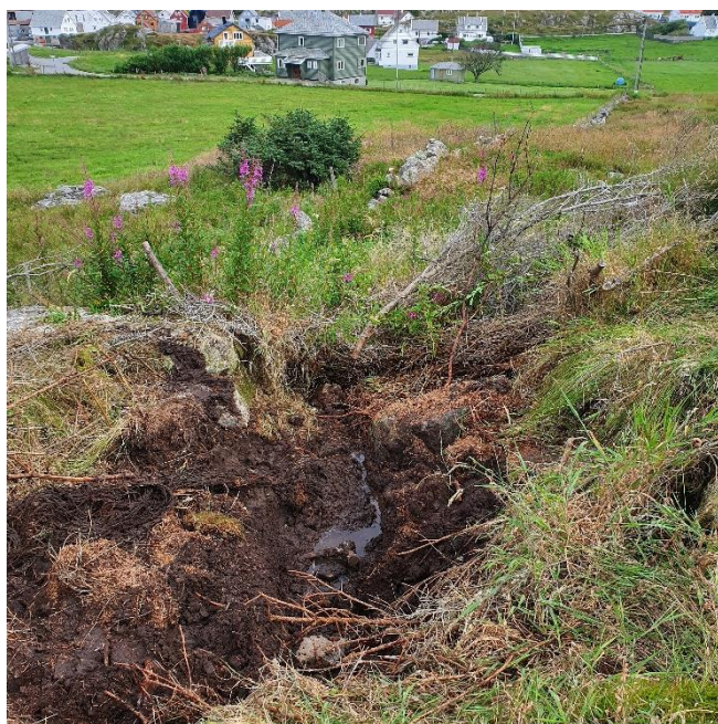
Vannlekkasje Varen i Nordvik
