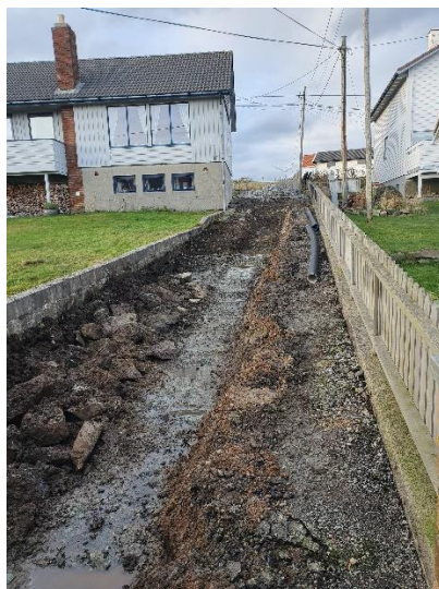
Fullføring av overflatevannsledning nær Jokerbutikken
