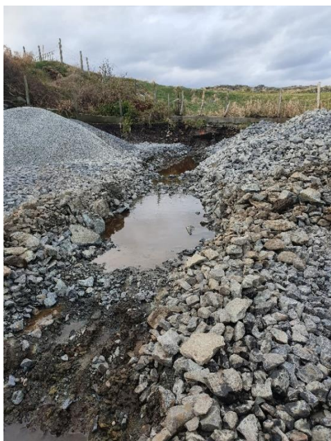
En vannførende kisteveite som var avsluttet i grensen til ett bolighus, Utsira kommune ryddet opp!
